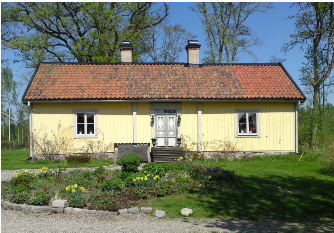
Flygelbyggnaden på Haneberg (2013). Byggnaden torde vara åtminstone från 1700-talet.
